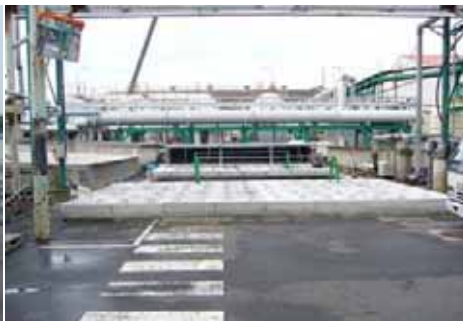
工場・排水槽のスラブ
