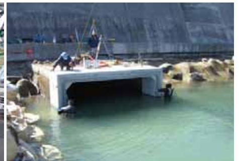
海洋構造物(写真は普通コンクリート)
