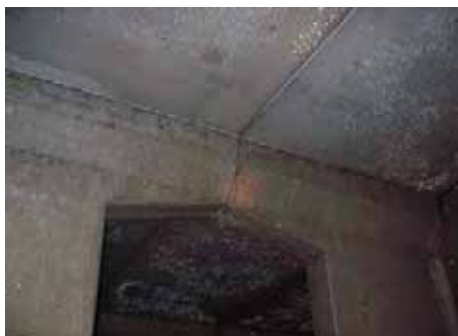
スタンドブロックと頂版スラブ接合部
