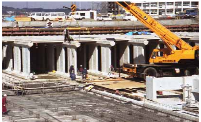
施工中の様子
