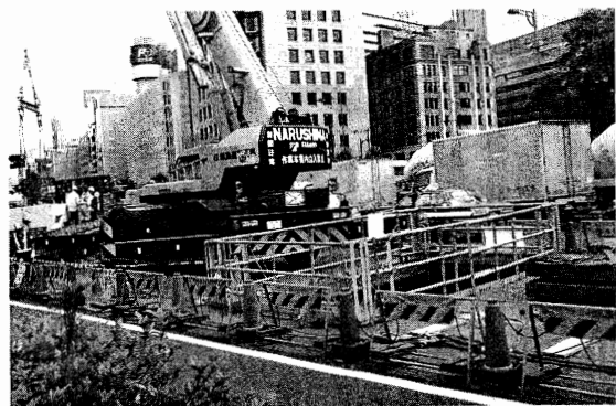
写真-8 部材投入口
