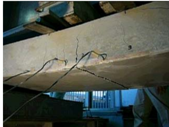
写真-4 FRP パネル装着型の破壊状況
