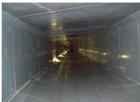
写真－8 更生改良後
