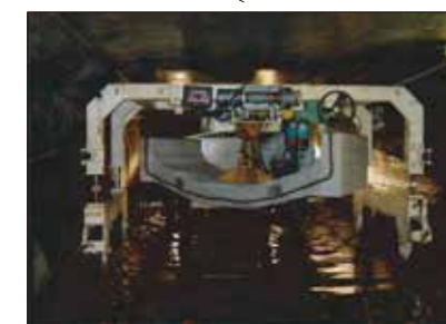
【下水を流しながら施工】
