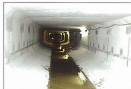
【更生後の管渠内部】
