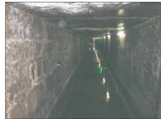
【既設管渠の内部】
