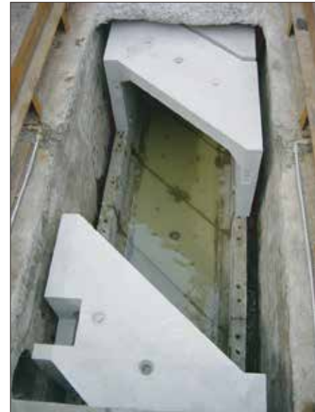
【RPC工法の投入孔】
