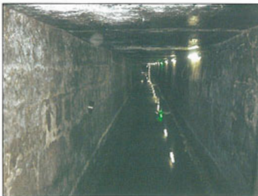
【既設管渠の内部】
