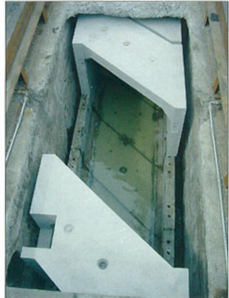
【RPC工法の投入孔】
