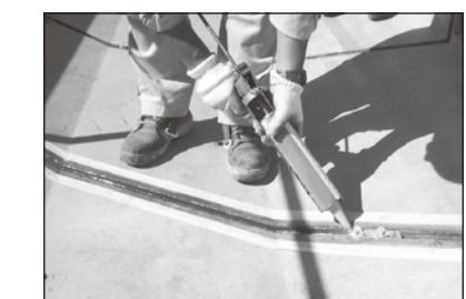
【GSシーラントの目地施工】
