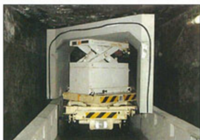
【上部ブロックの据付施工】
