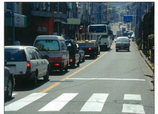
【水路に蓋掛けをした下水道管渠上の道路】
