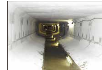
【更生後の管渠内部】
