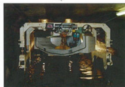
【下水を流しながら施工】
