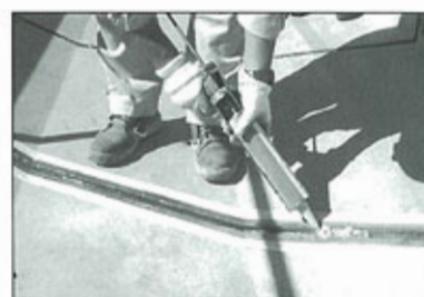
【GSシーラントの目地施工】
